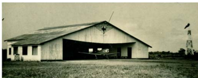
Figura 18 - Imagem do hangar que havia na Avenida FAB. Fonte: IBGE: < http://cod.ibge.gov.br/1K2F >
